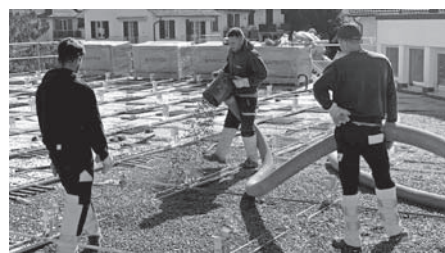
Aufbringen von Kies am 25.5.2020.
