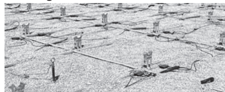
Beginn der Montage am 26.5.2020.
